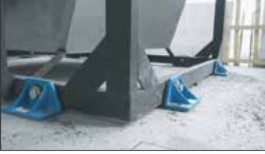
Sismik Sınırlama Sistemleri Seismic Restraint Systems
