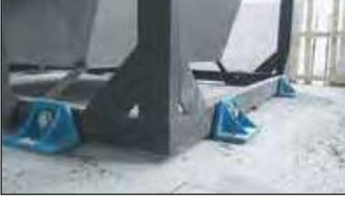
Sismik Sınırlama Sistemleri
